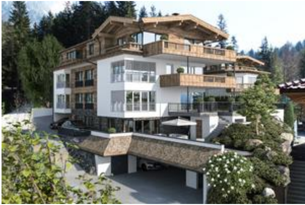
Ansicht Wohnanlage Scheffau
